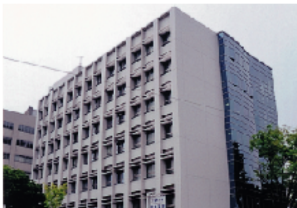
完成した新講議研究棟
